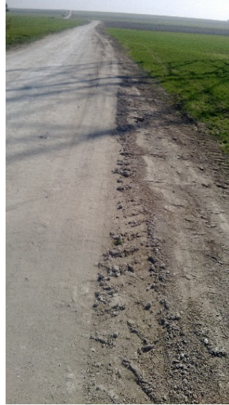
Figure 2 : Exemple de réseau enterré en accotement de chemin communal
